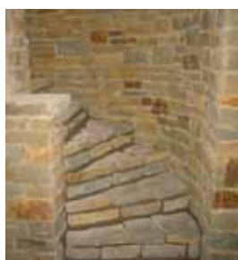
Murs et escalier
