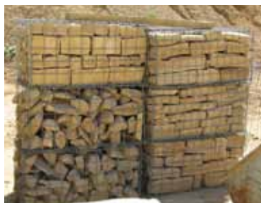
Remplissage de gabions
