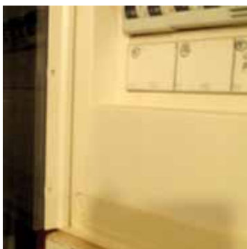
Charnière en matière plastique de coffret électrique
