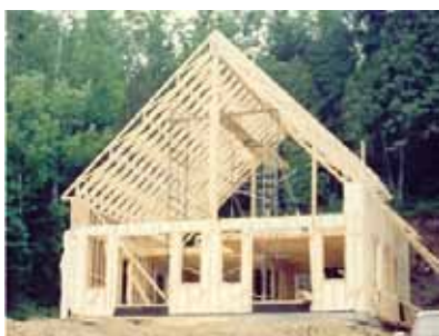
Placement de panneaux
