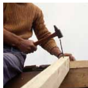
Construction de charpentes
