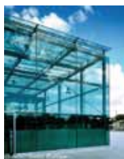
Façades de bâtiments
